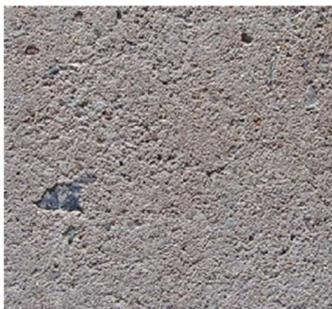
写真2. 高圧水洗目荒らし工法
